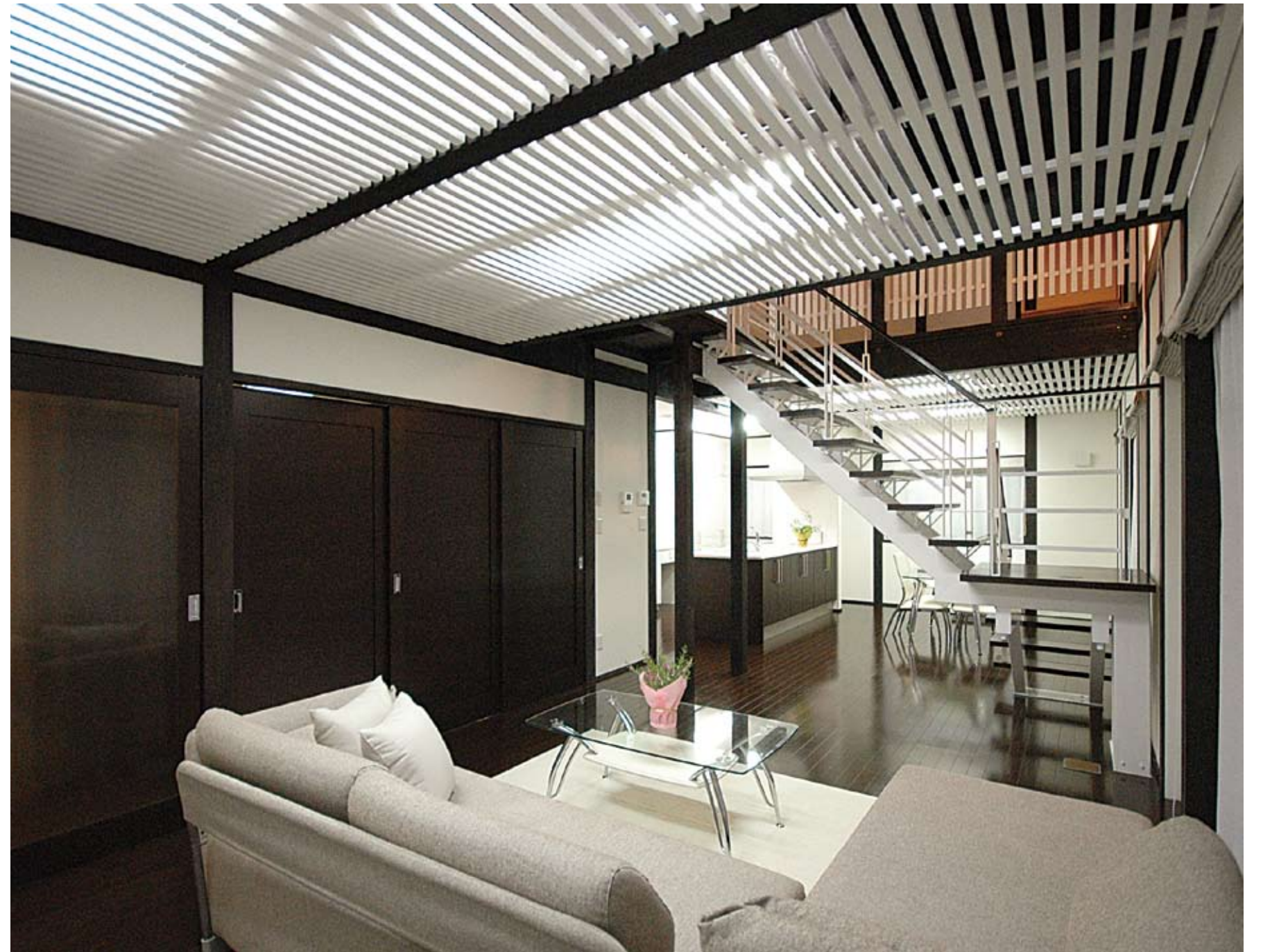
スチールのスケルトン階段が印象的なリビング。上部は吹き抜けにして、上階からの光をたっぷり取り込めるようにした。
